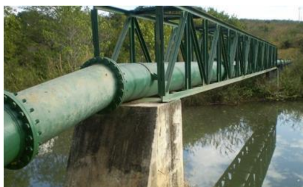
Figura 4 - Adução da água captada - Ribeirão Piancó.
