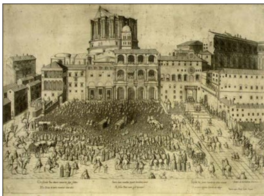
Figura 12. Estampa publicada por Antonio Lafreri, en 1555. Speculum Romanae Magnificentia . Muestra la basílica de San Pedro en construcción con la cúpula inacabada.
