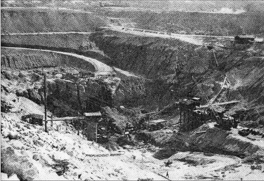
FIGURA 5 TRABAJOS EN LA PRESA OVIACHIC, 1955
