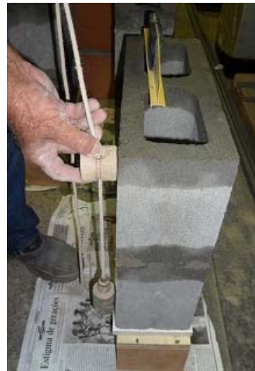
(b) Verificação do nível e do prumo
