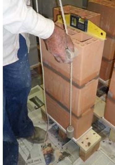
(b) Verificação do nível e do prumo
