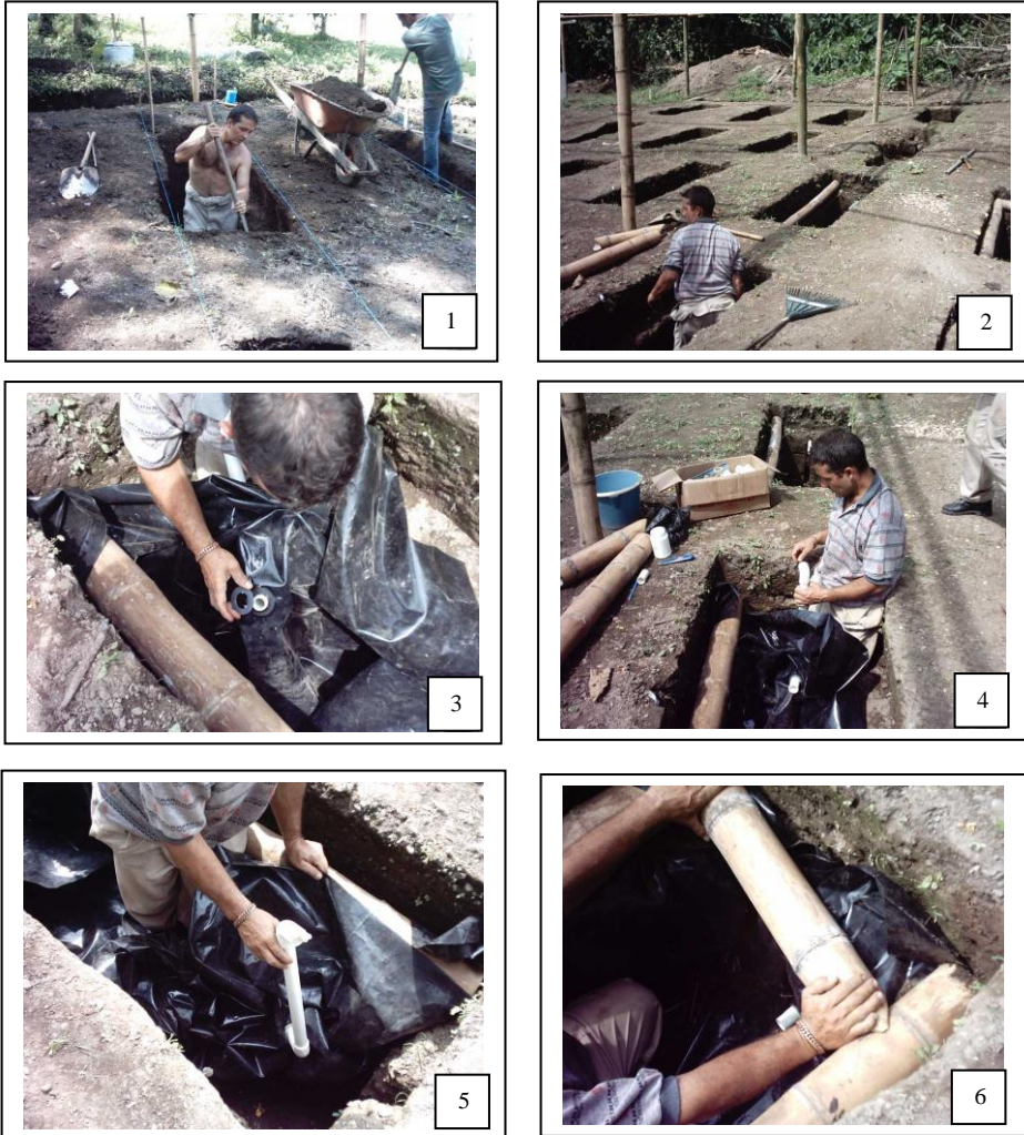
Figura 3.6. Construcción lagunas de experimentación. 1. Trazado y Excavación. 2. Panorámica de las 22 lagunas construidas. 3. Colocación del Agroblack y empaques de caucho. 4. Colocación de accesorios de salida. 5. Dispositivo de salida de cada laguna (toma desde el fondo). 6. Colocación del marco para fijación del material plástico.
