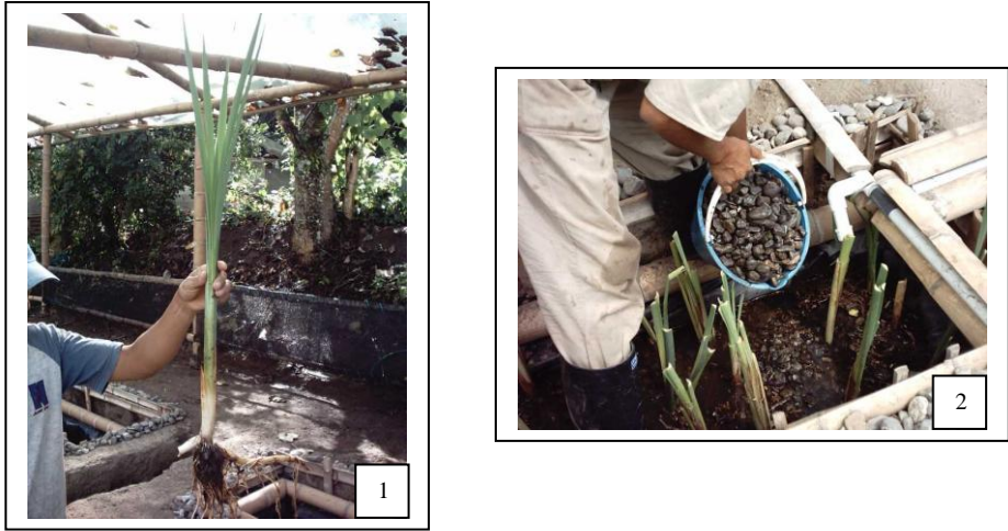
Figura 3.15. Siembra de la macrófita emergente. 1. Aspecto de las plantas sembradas en las lagunas. 2. Adición de la grava hasta alcanzar una altura ente 55 y 60 cm.
