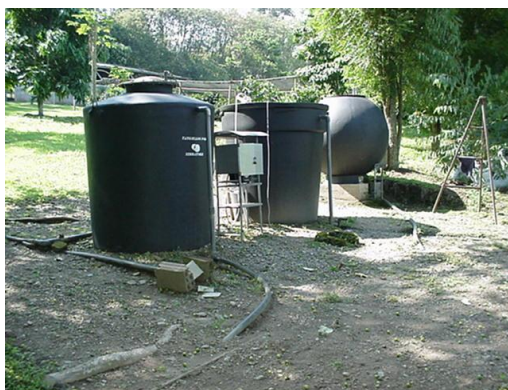
Figura 3.2. Reactores metanogénicos del SMTA. Fuente: Archivo fotográfico, Cenicafé.
