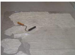
Fig. 165. Processo di applicazione della resina epoxi sopra la fibra di vetro.
