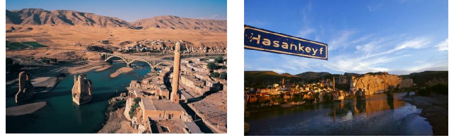
Şekil 5. Ilisu baraj ve HES alanı
